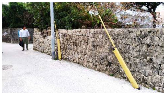
美装化された道路と石垣
