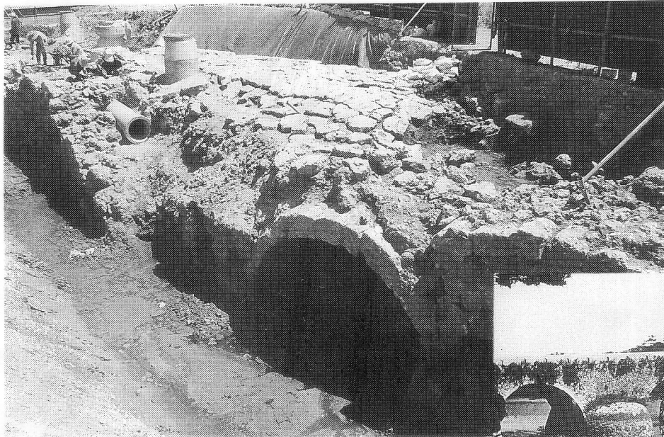
発掘調査で確認された 真玉橋の石橋遺構
