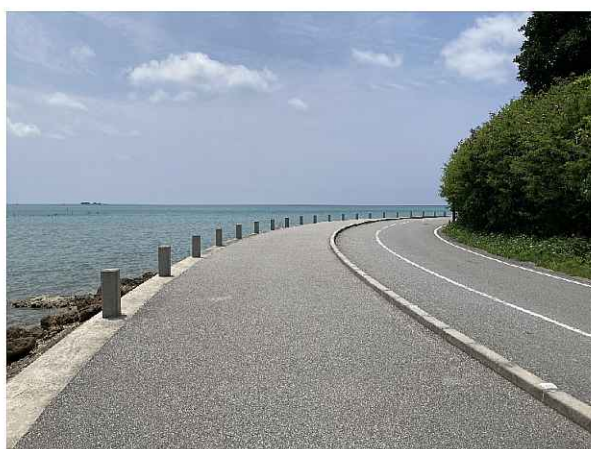
島内の一周道路 レトロ角柱が設置されている。一般的なアス ファルト舗装
