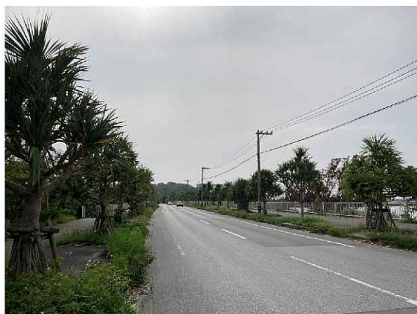
海中道路 一般的なアスファルト舗装。電線も存在。
