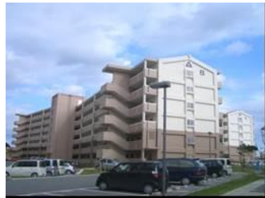
豊見城団地改良住宅
