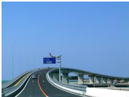
国道331号豊見城道路
