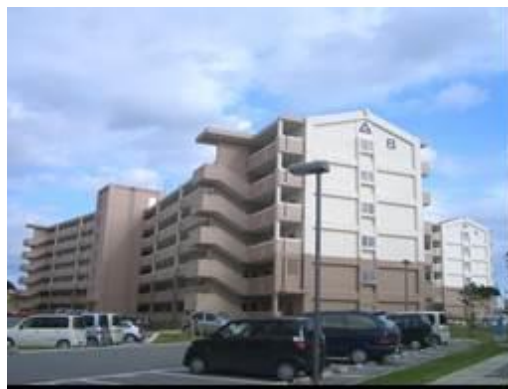
豊見城団地改良住宅
