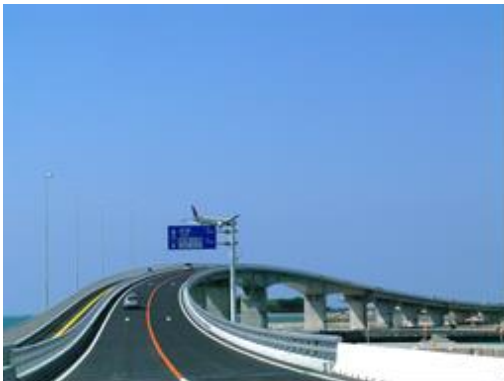
国道331号豊見城道路
