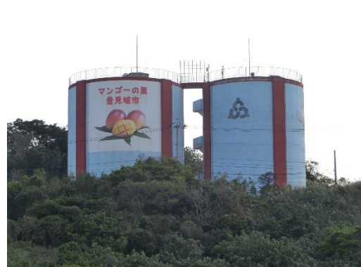
渡橋名配水池
