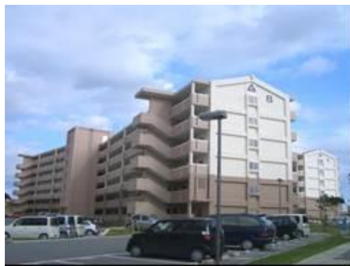
豊見城団地改良住宅
