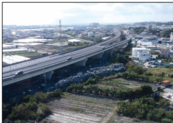
那覇空港自動車道
