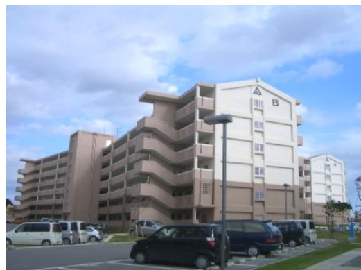
豊見城団地改良住宅
