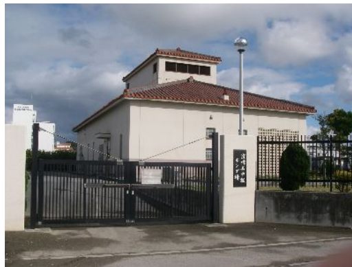
汚水中継ポンプ場
