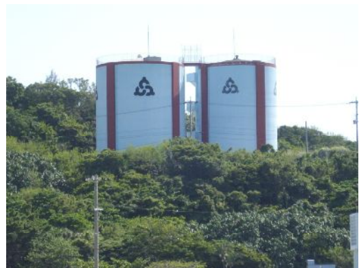
渡橋名配水池
