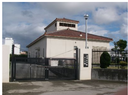
汚水中継ポンプ場
