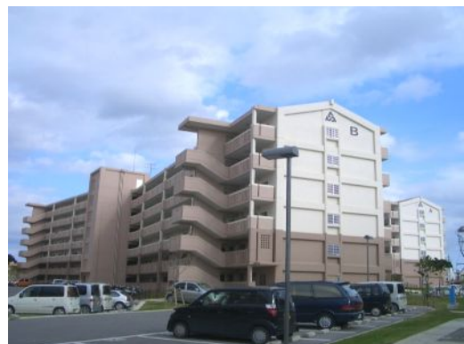
豊見城団地改良住宅
