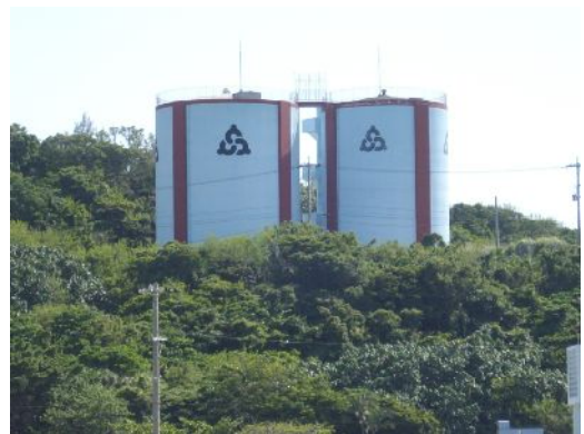
渡橋名配水池
