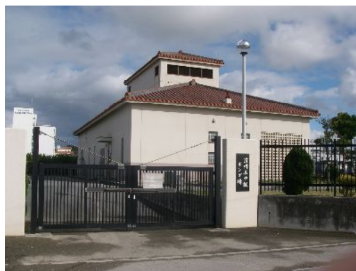
汚水中継ポンプ場
