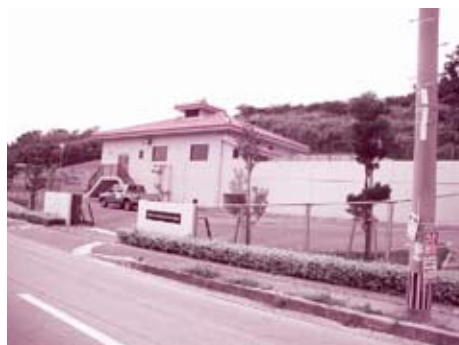
農業集落排水処理施設
