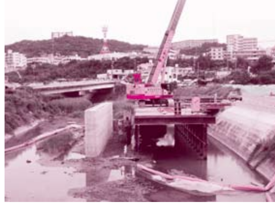
橋りょう工事の様子（谷口線）
