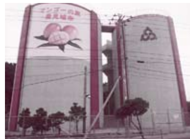
渡橋名配水池
