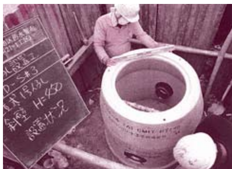
汚水管の配管の様子
