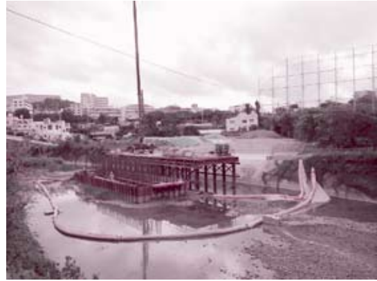
橋りょう工事の様子（谷口線）
