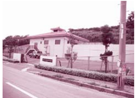
農業集落排水処理施設
