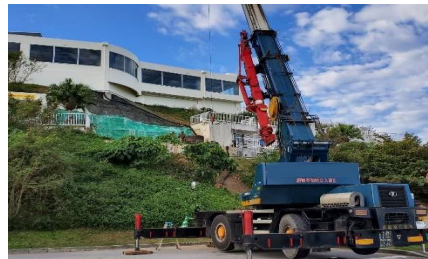
瀬長島不発弾処理施設設置写真
