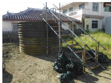
字伊良波不発弾処理防護壁設置写真
