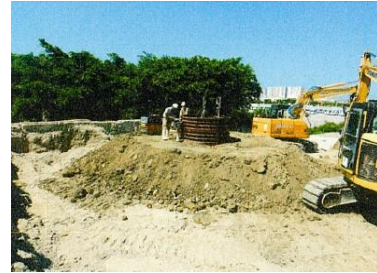
宇翁長不発弾処理防護壁設置状況写真
