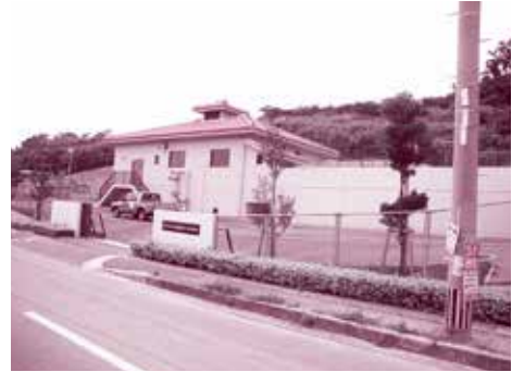
農業集落排水処理施設
