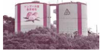
渡橋名配水池
