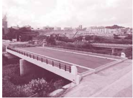
平成28年2月完成の谷口線太平橋（たいへいばし）
