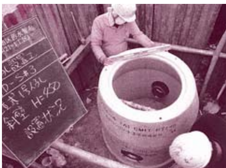
汚水管の配管の様子
