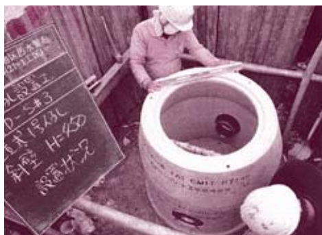
汚水管の配管の様子
