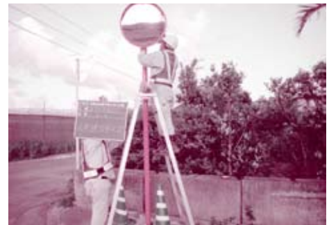
道路反射鏡の設置の様子
