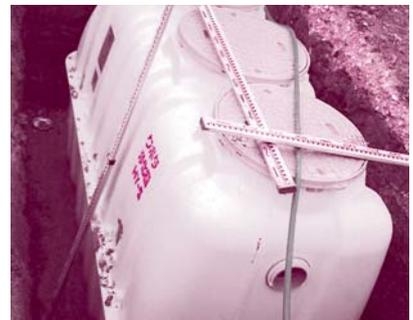
合併処理浄化槽の埋込
