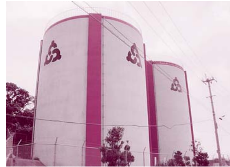
渡橋名配水池
