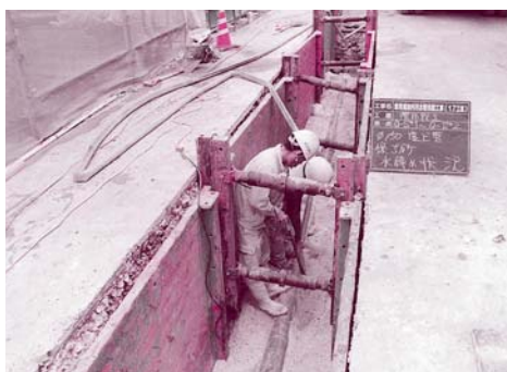
汚水管の配管の様子
