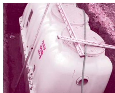
合併処理浄化槽の埋込
