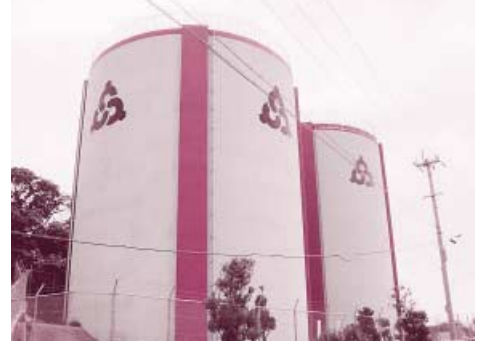
渡橋名配水池
