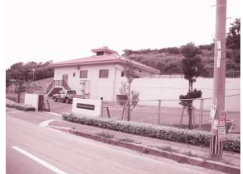
農業集落排水処理施設
