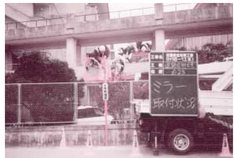
道路反射鏡の設置の様子
