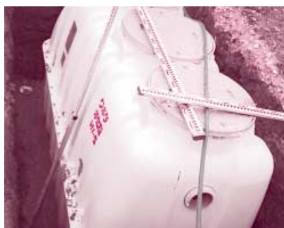
合併処理浄化槽の埋込
