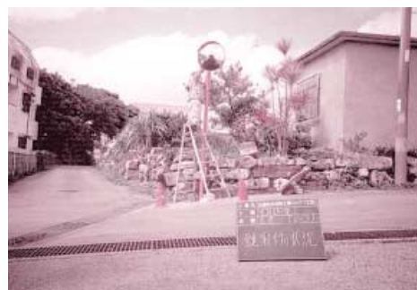
道路反射鏡の設置の様子
