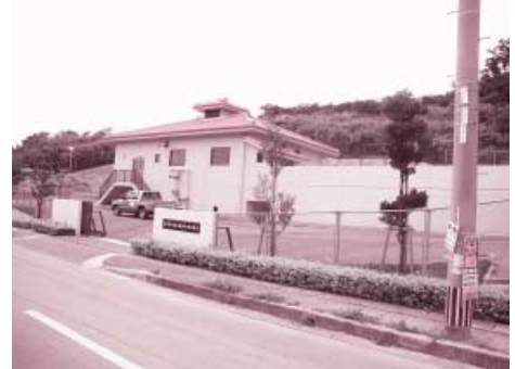
農業集落配水処理施設
