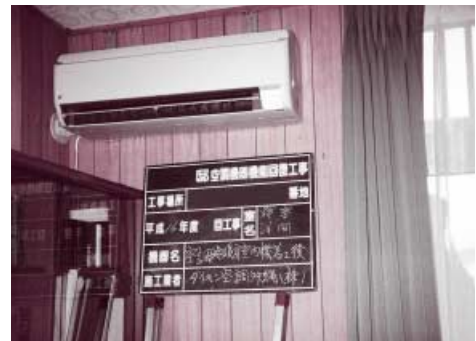
空調機器の設置状況
