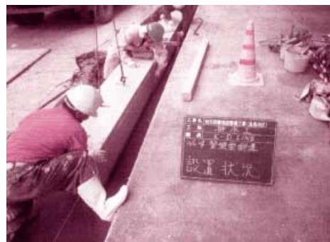
排水路整備工事の様子
