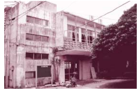
旧市役所庁舎が先進的なIT施設に生まれ変わります
