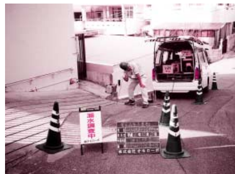
漏水調査の様子
