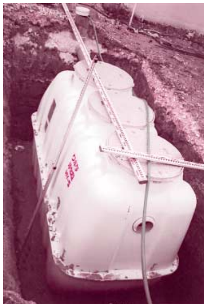
合併処理浄化槽の埋込
