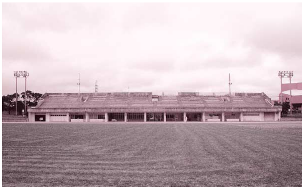
陸上競技場スタンドの防水塗装工事を行います
