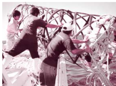
中層部分の投入
