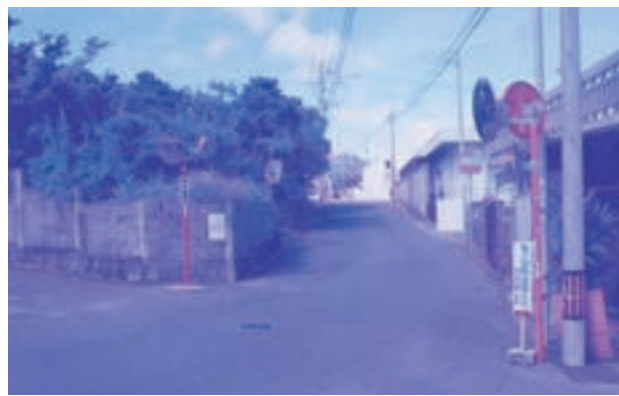
道路施設工事実施が待たれる市道425号線（渡嘉敷地内）
