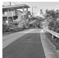
〈県道30号線施工完成写真〉
