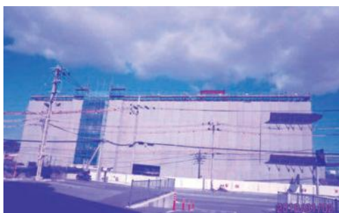
工事が進む新庁舎建築現場
