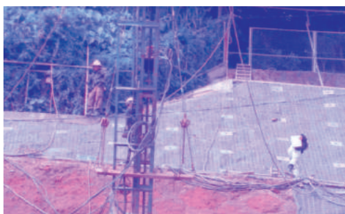
市道175号線、豊見城ニュータウン地内の工事は完了
