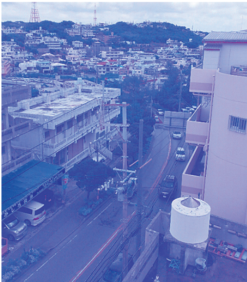
道路拡幅が早期に望まれる県道11号線 (第五工区)
