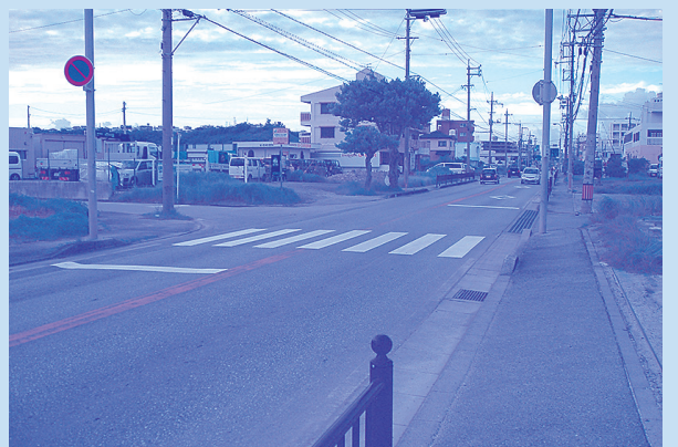
白線修復後 (字座安地内)
