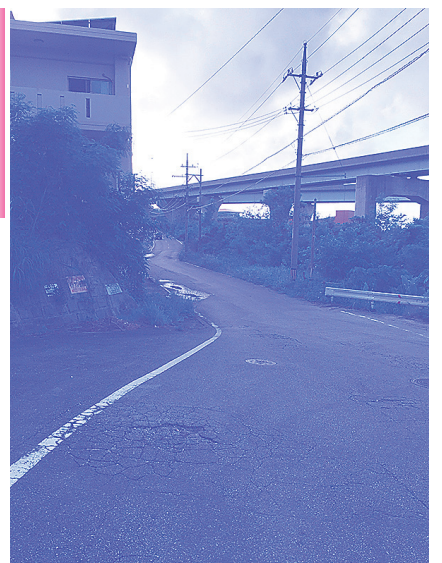
市道126・34号線(平良地内)の道路補修を
