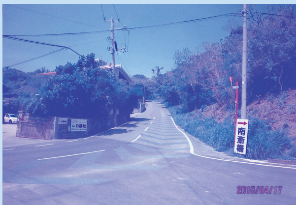
工事が始まる市道2号線
