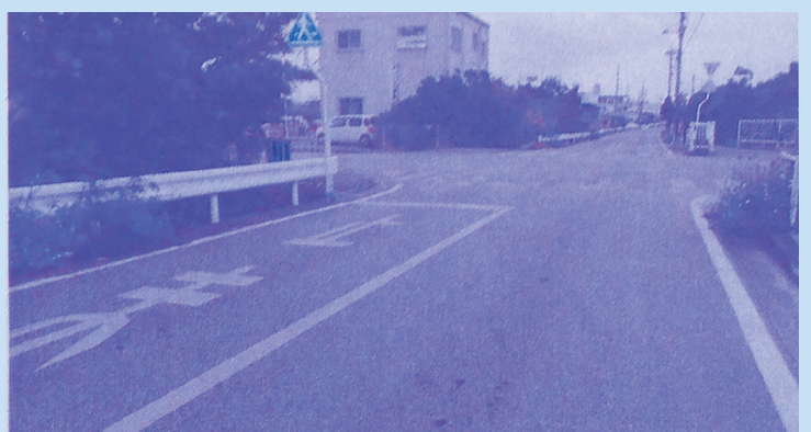
事故防止が必要な交差点 (与根地区：市道8号線、市道65号線)
