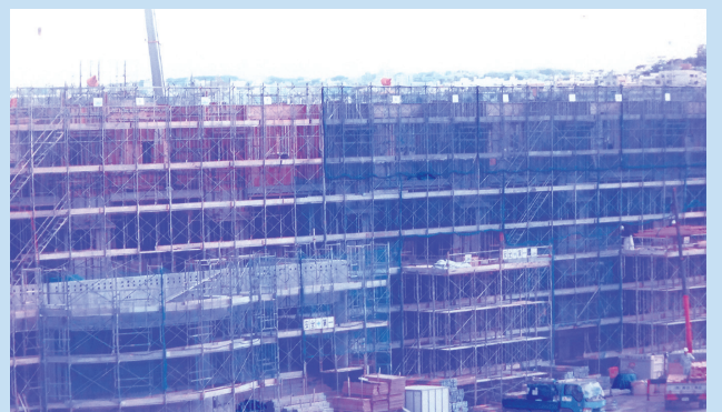
ゆたか小学校の建築工事風景
