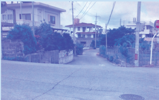
道路改良工事が待たれる市道 33 号線（饒波地内）
