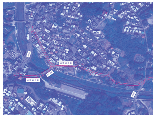
道路整備が複雑に絡む県道11号線(第5工区)
