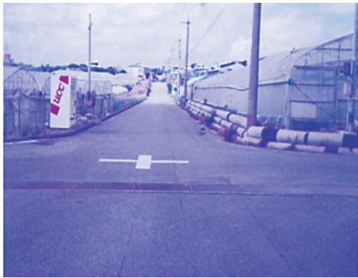
饒波地区農道にクロスマークの設置完了
