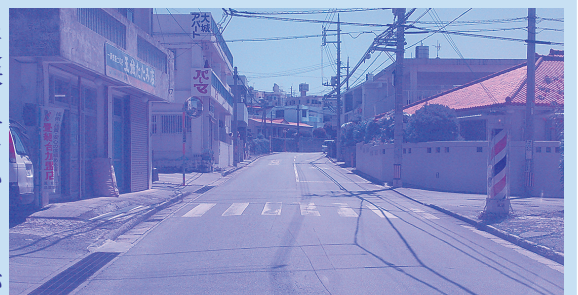
市道25号線(上田一渡嘉敷)の拡張工事が採択されました。
