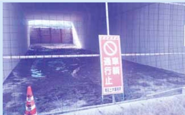
渡橋名県営団地入口へ接続予定のトンネル
