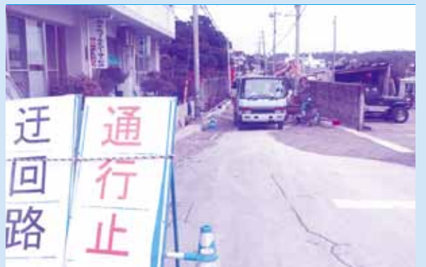
渡嘉敷集落内の道路舗装及び排水対策
