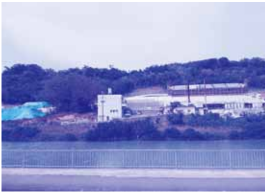
南斎場建設、擁壁決壊修復工事現場。3月供用開始？
