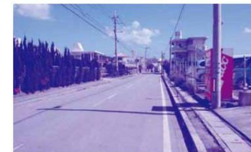
ガードレールの改修と道路整備が急がれる市道10号線
