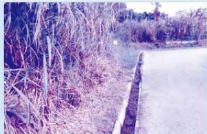
浚渫・除草が施された農道153号線(下流部分)
