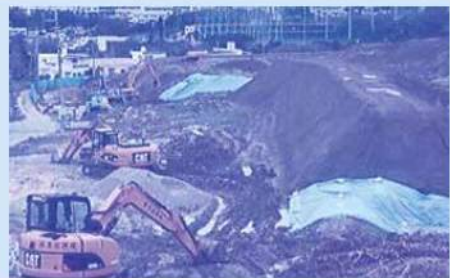
上田小分離新設校の造成工事が始まる...
