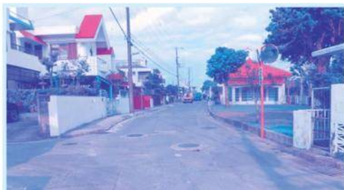
平成25年度改修予定の南自治会内道路(市道48号線)
