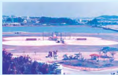
大規模改修によりさらに魅力ある球場へ!
