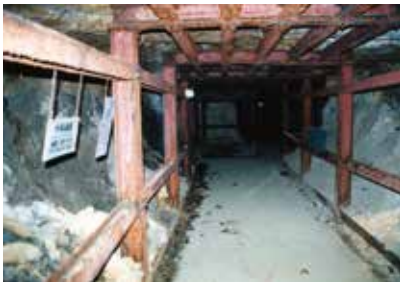
第二野戦病院壕内部(戦後) 鉄骨は戦後造られた
