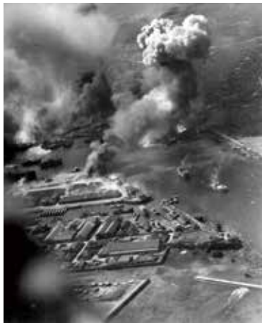
那覇の港湾施設 1944(昭和19)年10月 沖縄県公文書館所蔵(写真番号 108-28-4)
