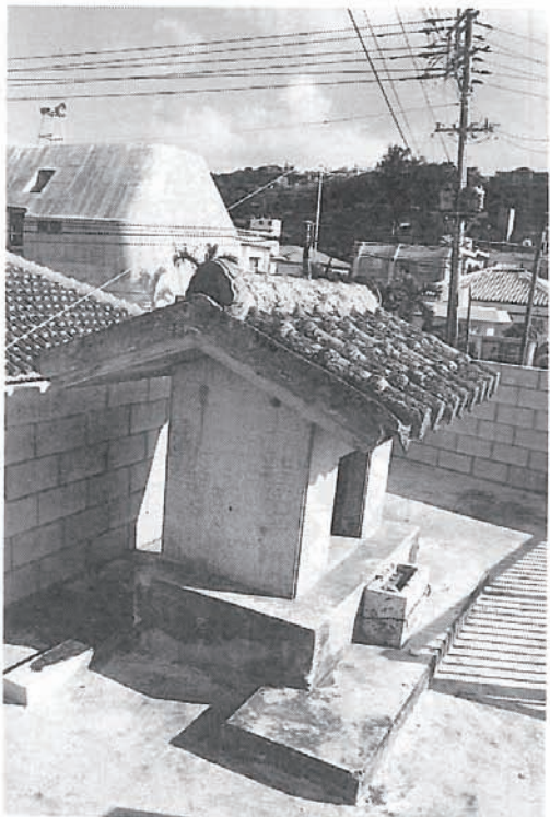
今も伝承され拝まれている祠（現在は、真玉橋梁工事のため字の集落寄りに移されている）
