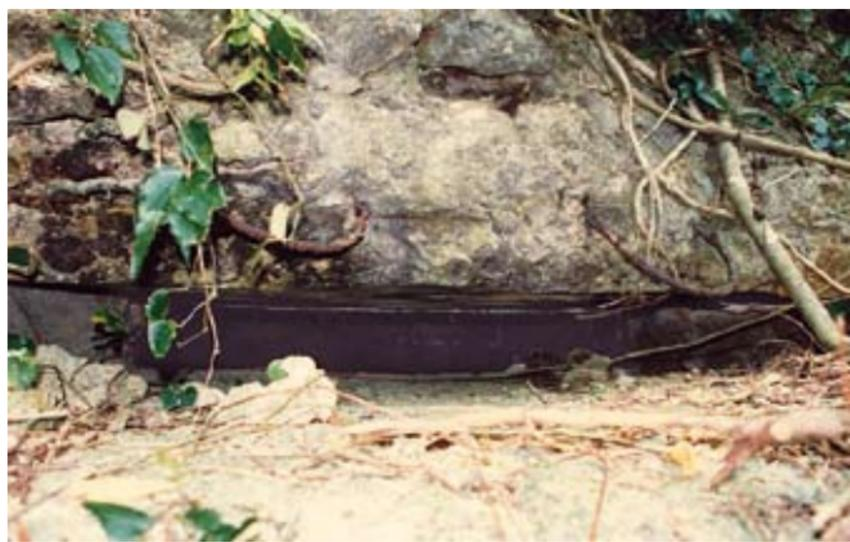
岩穴をコンクリートで覆い観測窓と推測される構造が確認できます
