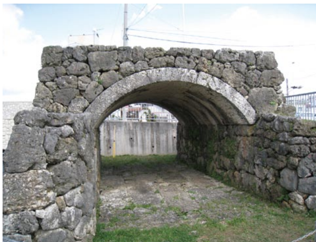
移設後の真玉橋
