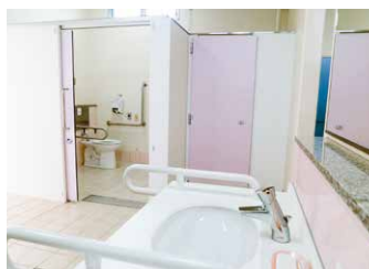
トイレ・シャワー室
