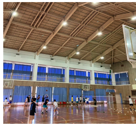
既存体育館の様子
