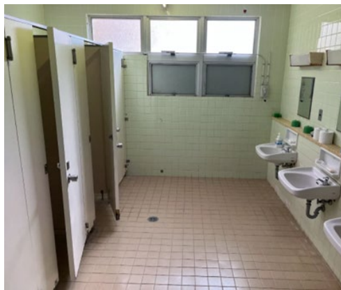
既存トイレ(体育館)の様子
