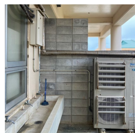
既存コンクリート ブロック壁
