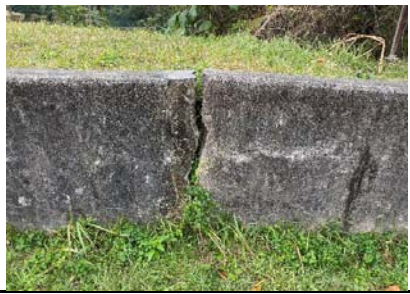
8 擁壁の破損
