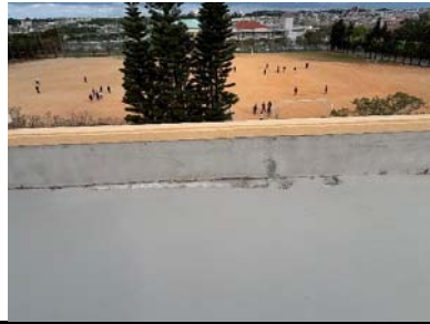
2 防水層の劣化・破損
