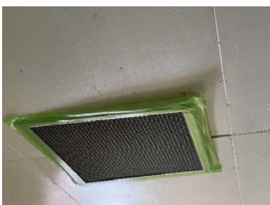
22 設備機器の浮き
