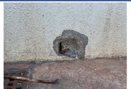
6 外壁の破損
