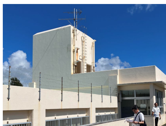
既存の高架水槽
