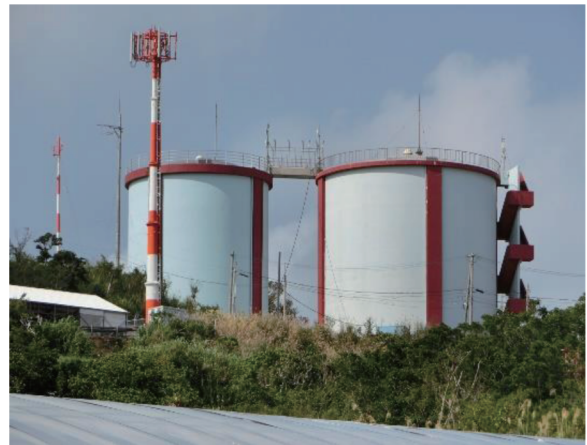
平良第1・第2配水池 (字平良 585-2)
