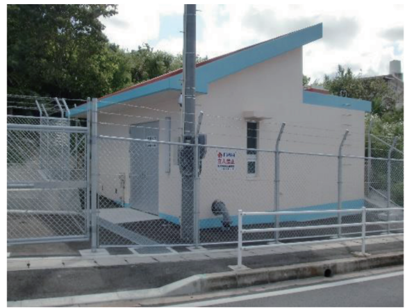
高安後原送水ポンプ場 (字高安 828)
