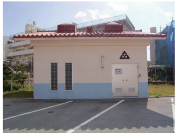
高安前原送水ポンプ場 (字高安 358-2)
