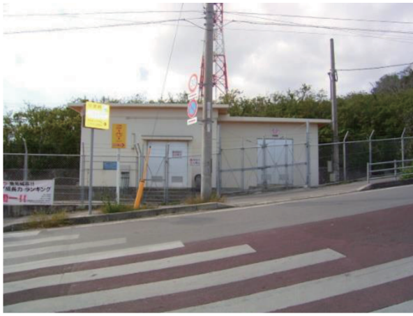
渡橋名送水ポンプ場 (字渡橋名 222-5)
