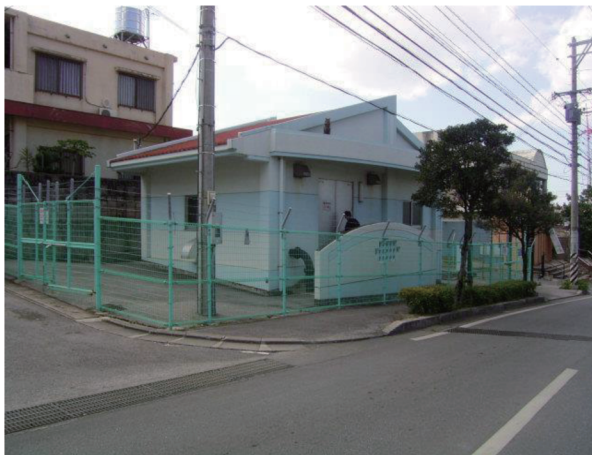
ニュータウン送水ポンプ場 (字根差部 426-17)
