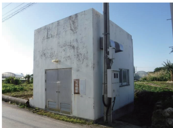
保栄茂中継ポンプ場（字保栄茂 297-2）
