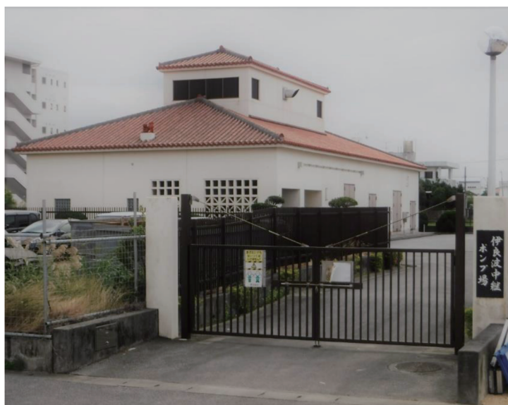
伊良波汚水中継ポンプ場（伊良波 677-9）
