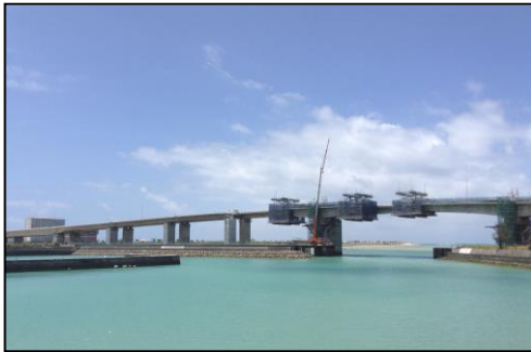
沖縄西海岸道路（豊見城道路）
