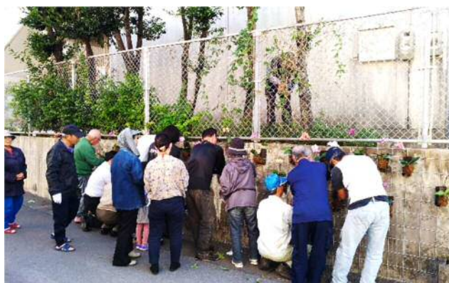
公民館東側の壁面に取り付けていきます
