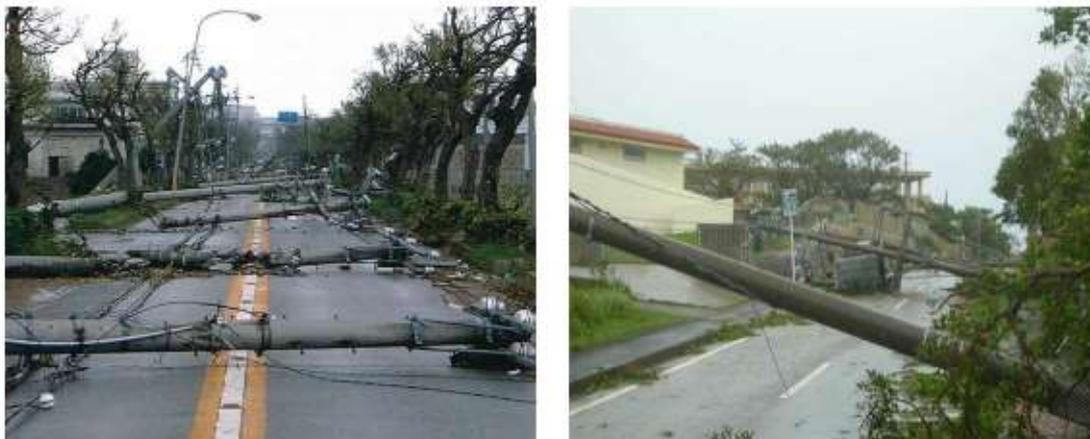
写真一 台風による電柱倒壊状況
